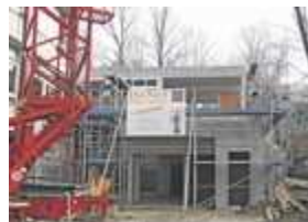
Im Rohbau steht die Schulmensa in Essingen. (Foto: beb)
